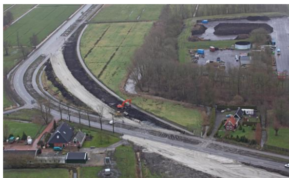
Foto werkzaamheden N358, (Bron: www.fryslan.frl )
